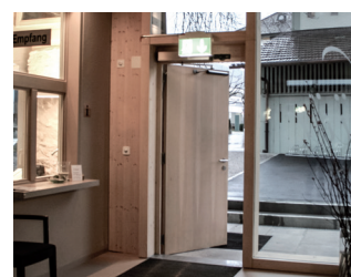
Portes d'évacuation / issues de secours
